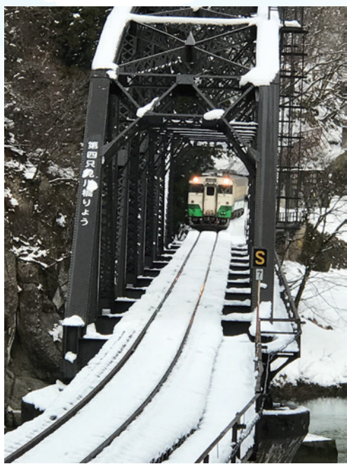
◀第四只見川橋梁
