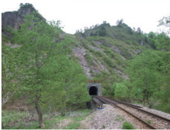
▲六十里越トンネル只見側
