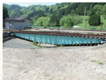
▶会津川口駅転車台
