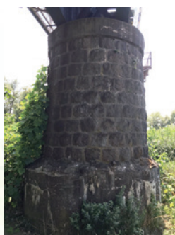
▶大川橋梁の橋脚
