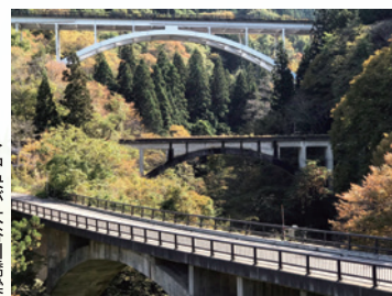
▶中央が大谷川橋梁
