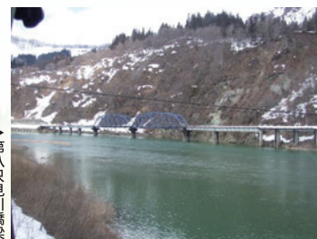
第八只見川橋梁
